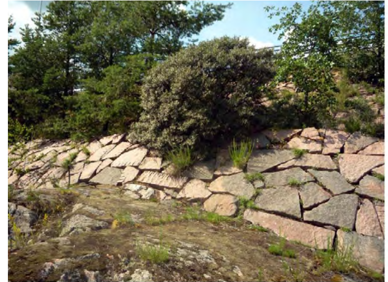
Kuva. Lohkovivellä verhoiltua siltapenkereen terrassointia on pehmennetty tyrni-, tervalepää- ja mäntyistutuksilla. Naantali.
